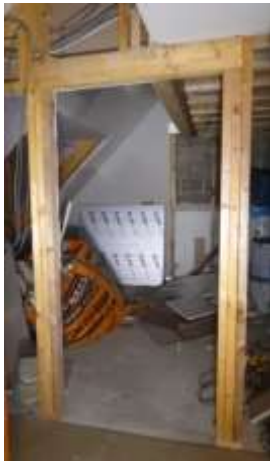
(a) Door frame
